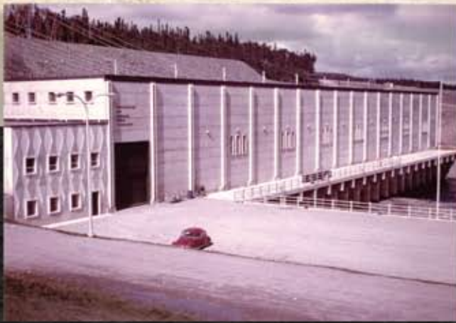
6.52 Bay d'Espoir powerhouse
